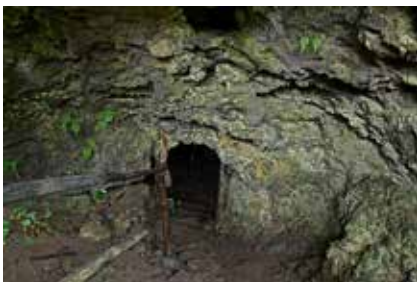
Entrée du tunnel Los Piratas
