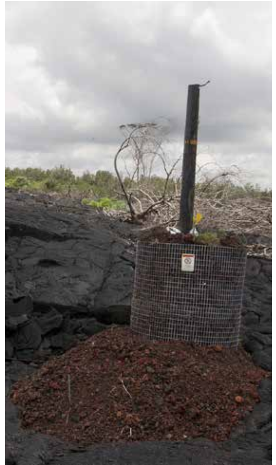
Poteau électrique protégé mais cependant pas épargné par la chaleur de la coulée
