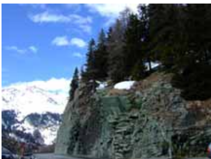
Marmorera, vers la digue
