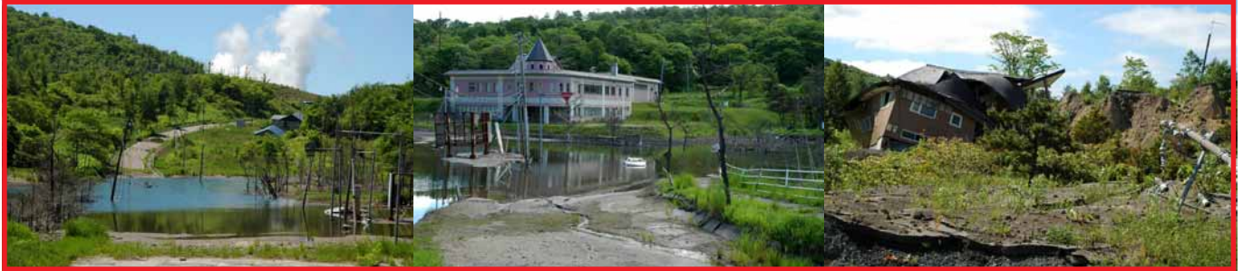
Dégâts de l'éruption 2000 de l'Usu
