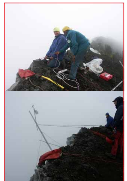
Montage de la station météo au sommet du volcan
