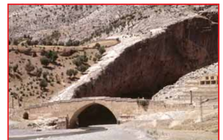
Pont de Septime Sévère
