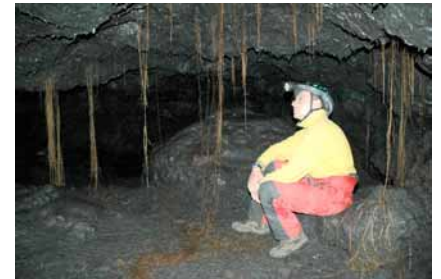
La végétation plante ses racines à travers le toit du tunnel Gruta das Torres
