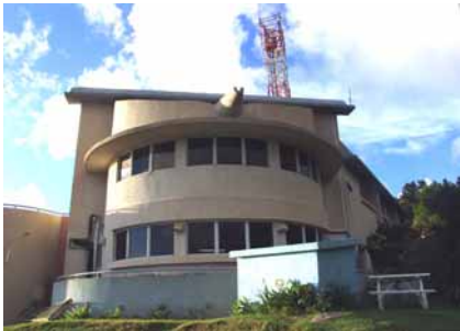
Bâtiment du MVO
